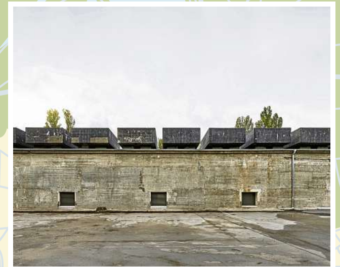
Der 1942 erbaute BASA-Bunker diente der Telekommunikation und sicherte im Zweiten Weltkrieg die Logistik von Truppenbewegungen.
